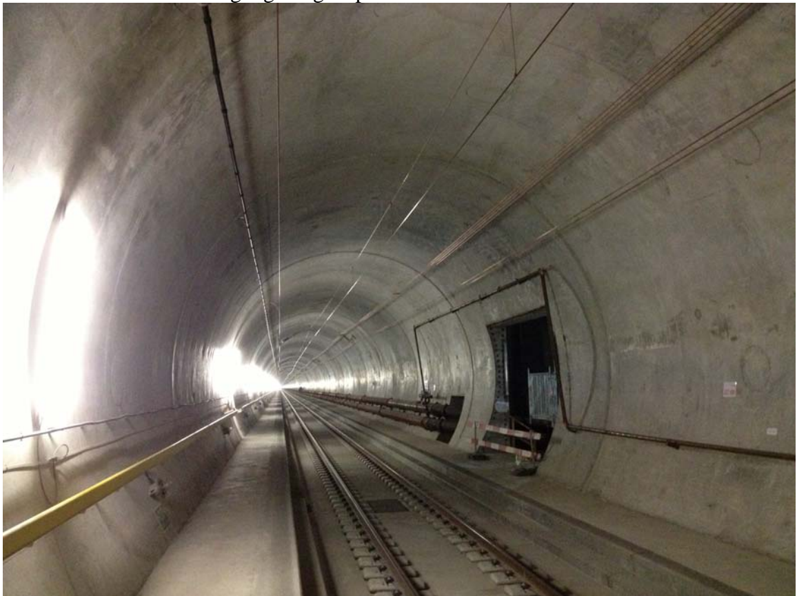
Der noch im Bau befindliche, längste Eisenbahntunnel der Welt mit 57 km am Gotthard, ab 2016 werden Züge hier mit 250 km/h auf max. 500 Meter über NN die Alpen unterqueren.
