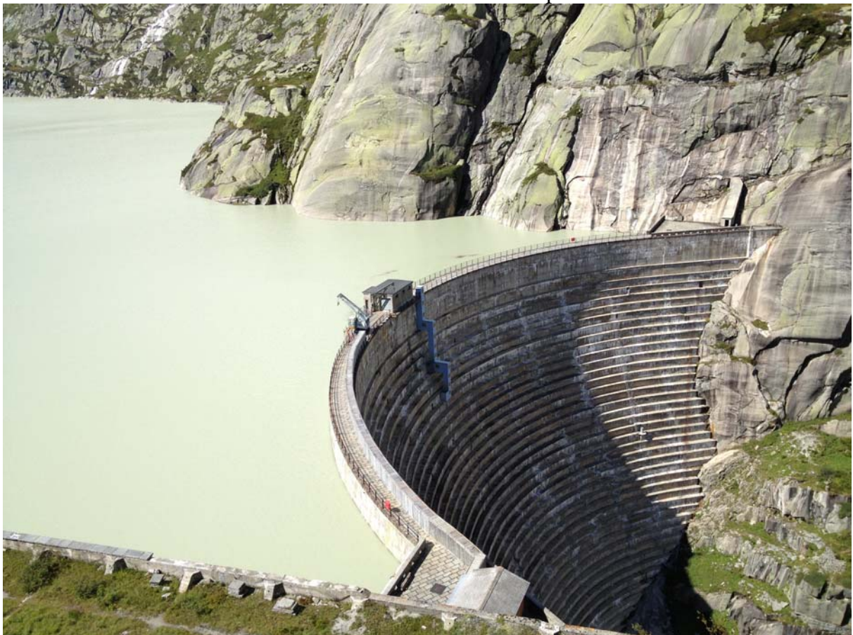
Stausee am Grimsel, das Wasserkraftwerk Grimsel 1 wartete auch noch mit einer Führung.
