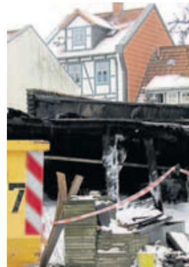
So sah die völlig heruntergebrannte Möbelwerkstatt am Tag nach dem Brand aus.
